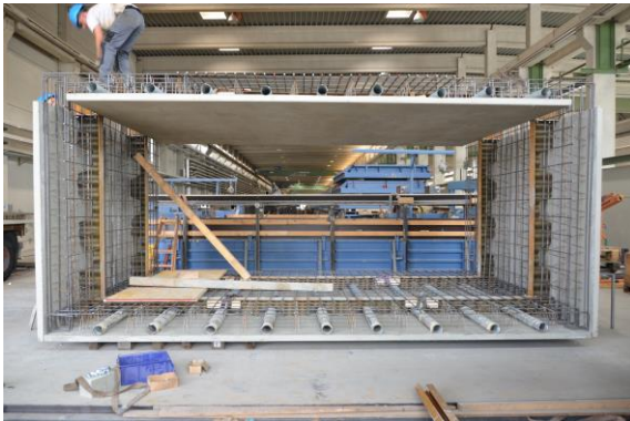
Abb.15: Zusammenbau des Prototyps durch Schraubverbindungen an den Stahlträgern
