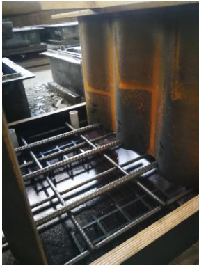
Abb.7: Stahlträger mit durchgesteckten Querstäben als Verbinder
