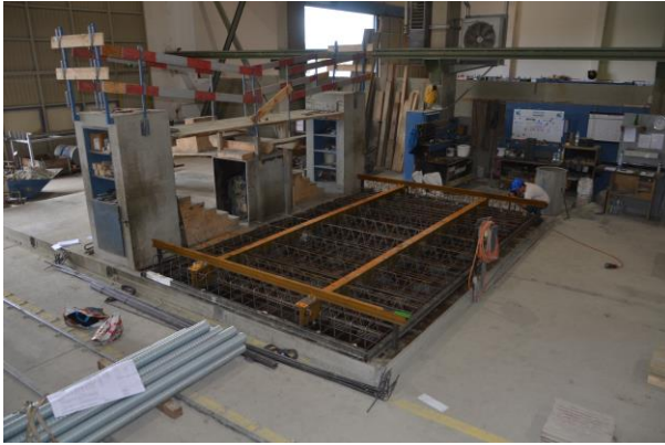
Abb.13: Bewehrungskorb einer Platte mit eingelegten T-förmigen Stahlträgern
