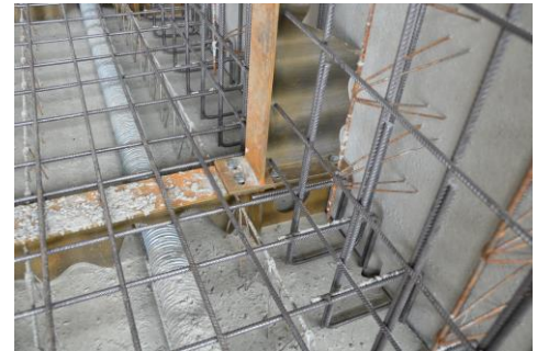
Abb.12: Detail untere Rahmenecke nach Zusammenbau des Segments
