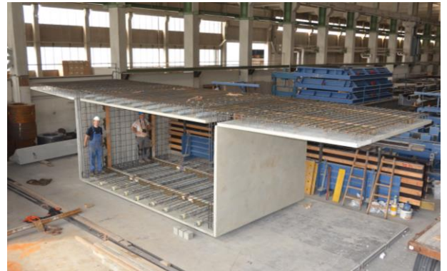
Abb.16: Prototyp nach Fertigstellung aller Arbeiten
